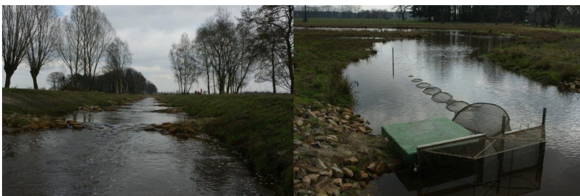
Figuur 19. De bekkenpassage Kaweise Loop (links, 12-03) en de bovenstroomse inlaat van hevelpassage met fuik en koppelstuk (rechts, 12-03)
